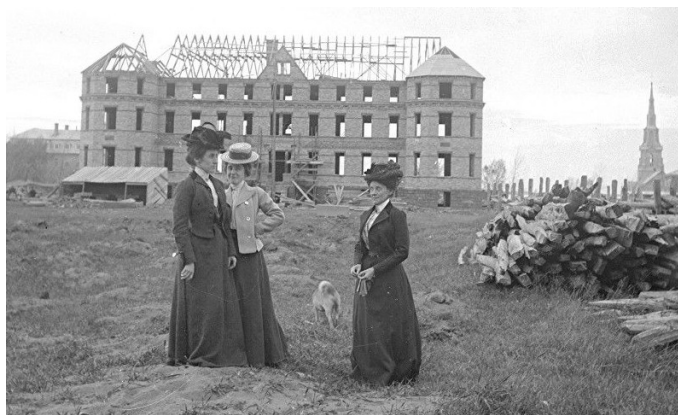
Photographe inconnu – Musée régional de Rimouski. | En construction, le deuxième évêché (1901).
