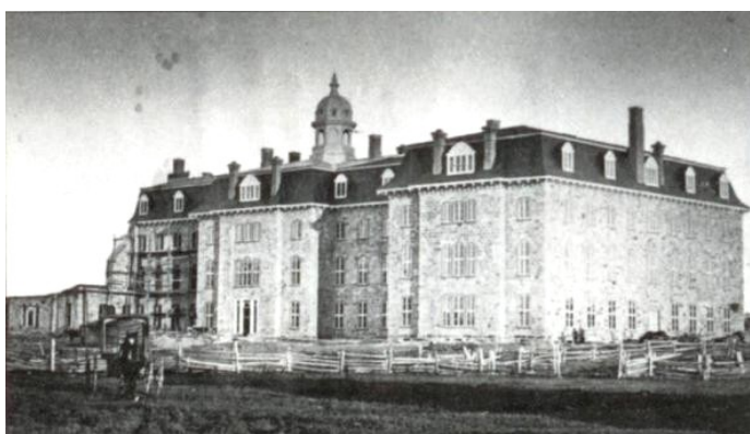
| Le 2 e Séminaire projeté par Mgr Langevin en décembre 1868, construit à partir de septembre 1869 jusqu'en mai 1876. Début des cours le 2 juin 1876.
