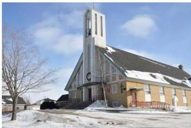
L'église de Luceville est appelée à changer de vocation. Photo: Sonia Lévesque
