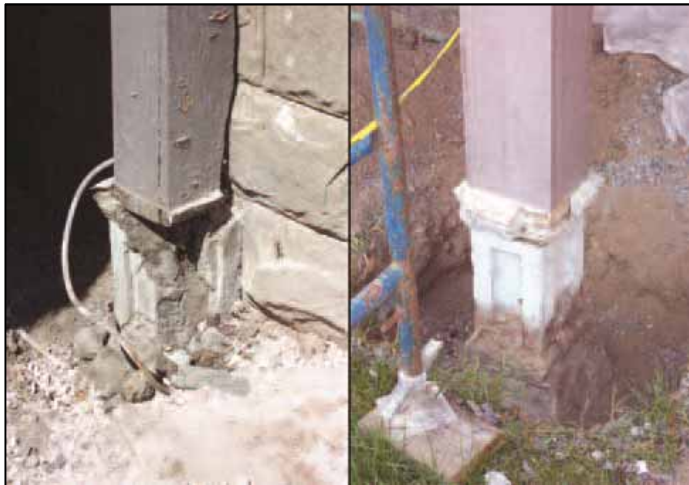
Piliers de la galerie avant les travaux
