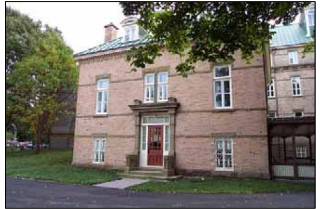
Travaux finalisés à l'arrière de l'archevêché
