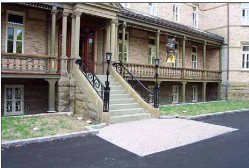
L'escalier restauré et l'entrée principale réaménagée
