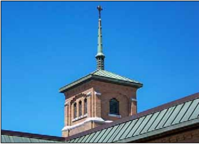
Une vue du campanile sur la toiture. Photo : Yves-Marie Mélançon.
