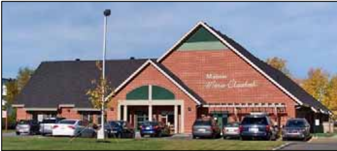
La Maison Marie-Élisabeth située au 76 de la 2 e Rue Est, entre les rues Hupé et Belzile à Rimouski. Photo : Yves-Marie Mélançon.
