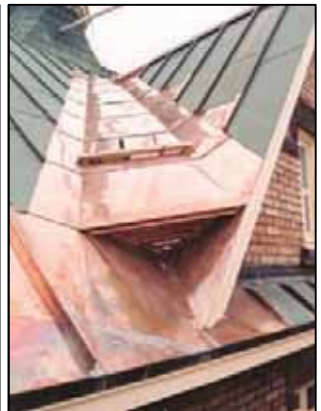
Noue ventilée après la réparation
