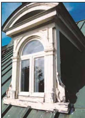
Lucarne avant les travaux
