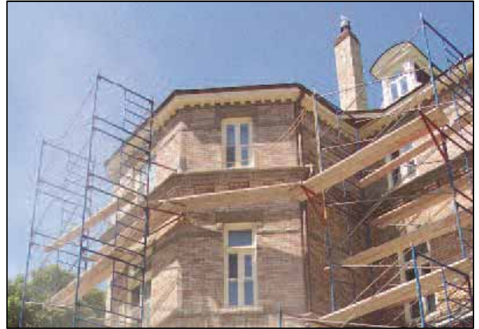
Évidement des joints de maçonnerie
