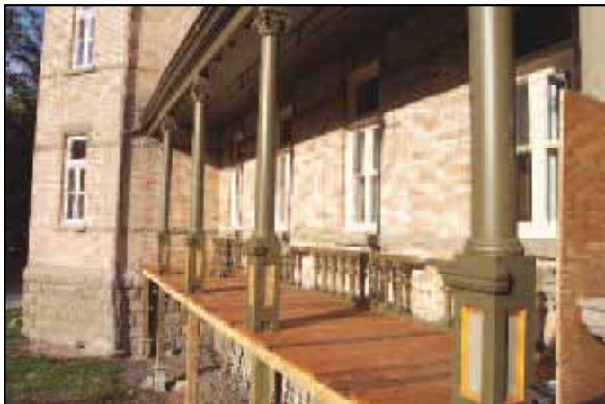
Restauration de la galerie avant
