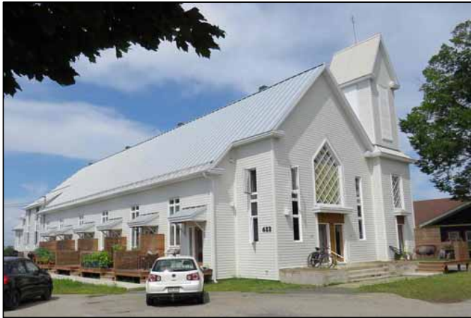
L'église de Nazareth convertie en un immeuble à appartements. Photo : Société rimouskoise du patrimoine : https://srdp.ca/fiche/1849/ . Courtoisie.
