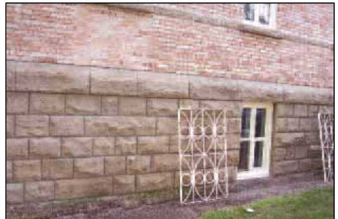
Le rejointoiement de la maçonnerie est terminé
