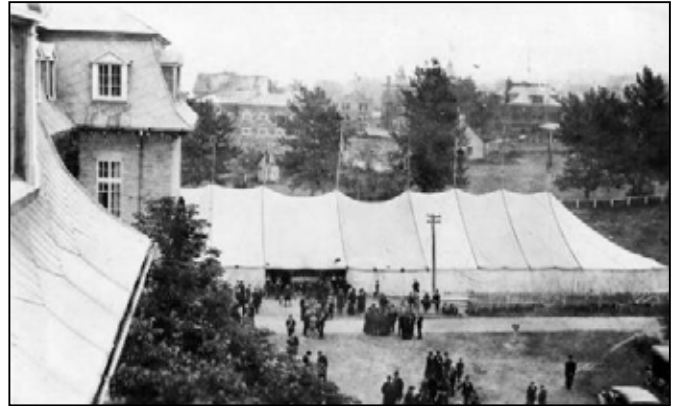
Conventum des 22-23 juin 1920 : Après le banquet du 23 juin 1920. On y voit le chapiteau dressé pour l'occasion à l'est du séminaire. Photographie inconnu. ARSR, 198.420, R-52.
