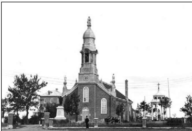
La vieille église de Pointe-au-Père vers 1940 (démolie en 1958). Photographie inconnu. AAR. (Voir le Billet #496.)
