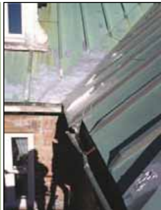
Noue 1 avant les travaux
