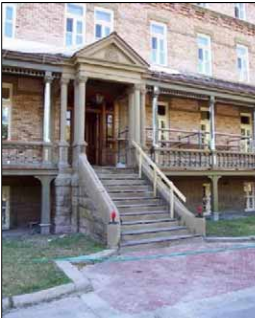
L'escalier de l'entrée principale avant sa restauration
