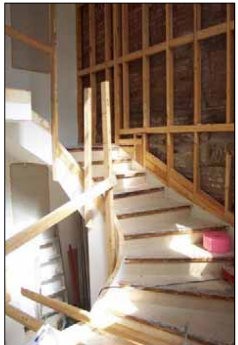
Une des pièces du mur ouest (au 2 e étage) qui ont été démolies et remplacées par un escalier partant du sous-sol jusqu'au 4 e étage
