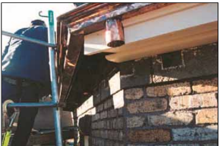
Restauration des gouttières et des débords de toit
