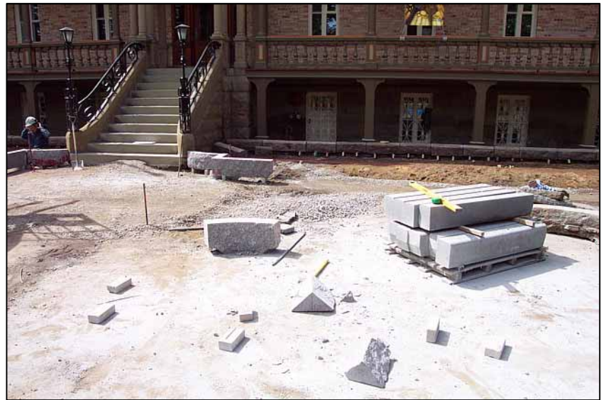
Les travaux de restauration de l'escalier et d'aménagement de l'entrée principale
