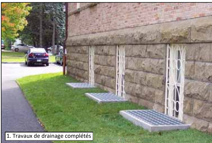
1. Drainage des fondations
