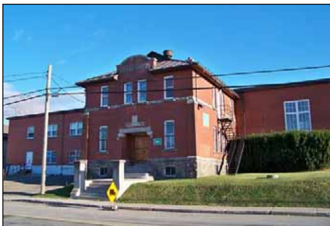
Situé au 65 est de la rue Saint-Jean-Baptiste, l'ancien Manège militaire existe depuis 1910-1911, avant la guerre de 1914-1918. Photographie: Yves-Marie Mélançon.
