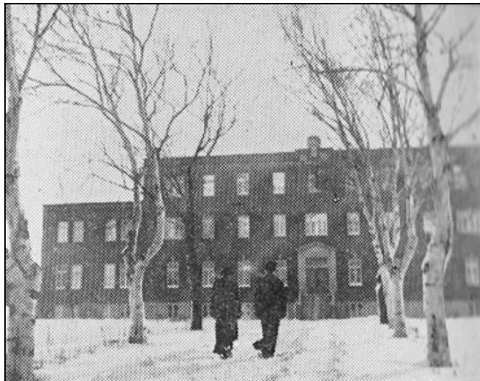
Le nouveau Grand Séminaire établi dans la Maison Sainte-Thérèse à l'automne de 1943. C'était avant la construction d'une nouvelle aile en façade entre 1945 à 1947. Photographie inconnu. Source : Le Centre Saint-Germain , juin 1945, p. 30.
