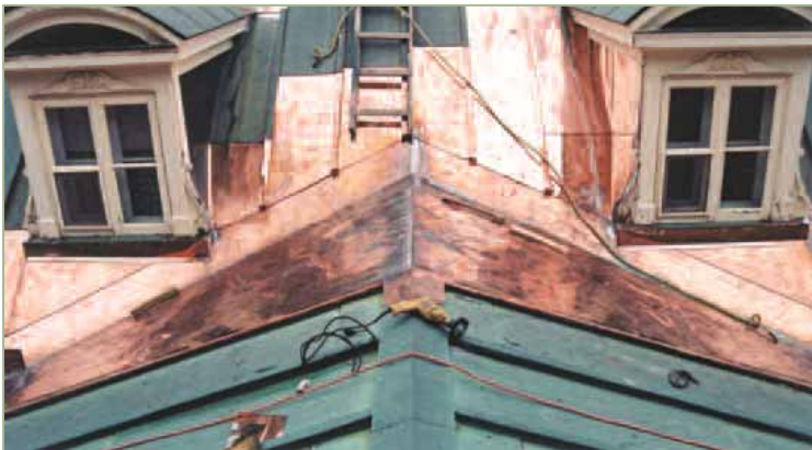
Réfection d'une partie de la toiture
