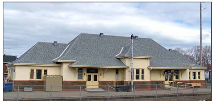
La vieille gare du Canadien National construite en 1937. Photographe : Yves-Marie Mélançon.
